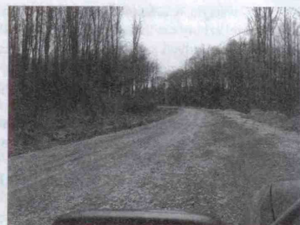
Foto.7- te ostatnie metry po stronie podkarpackiej - nadal czekają na asfalt..
