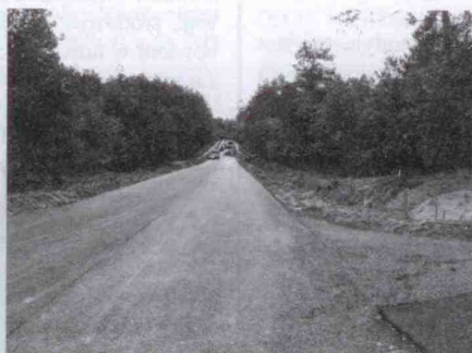
Foto.4 A tak we wrześniu, ten sam odcinek drogi do lasu wygląda już też na skończony a widoczni na końcu pracownicy i maszyny zajęci byli już tylko „kosmetyką” czyli rowami odwadniającymi kładzeniem folii i krawężnikami..
