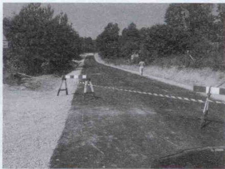
Foto.1- 27 lipca 2013 ten sam odcinek drogi dojazdowej do Siedlisk jest już prawie skończony, brakuje tylko kosmetyki, czyli pomalować pasy itp.
