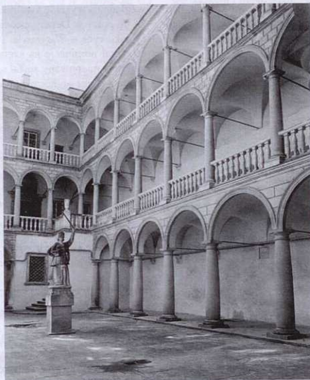
Lwów. Kamienica Królewska, początek XVII w.
