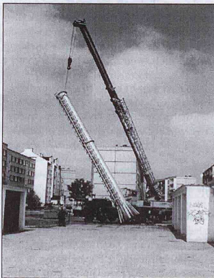
Demontaż komina na osiedlu Jagiellonów w Lubaczowie
