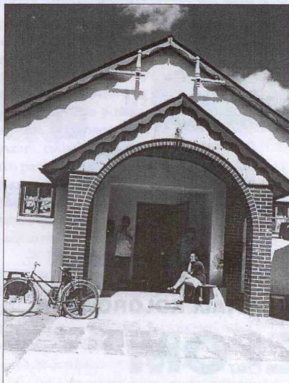
Na zdjęciu: wyremontowany budynek sklepu.
