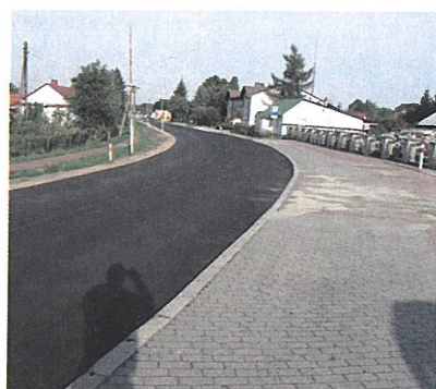
Szerokość drogi jest teraz większa, a obok Cmentarza ma nachylenie kilku stopni, co zwiększa bezpieczeństwo jazdy i odprowadzi wodę deszczową do rowu, oczyszczanego co widać w głębi po lewej stronie. to wszystko naprawdę cieszy!
